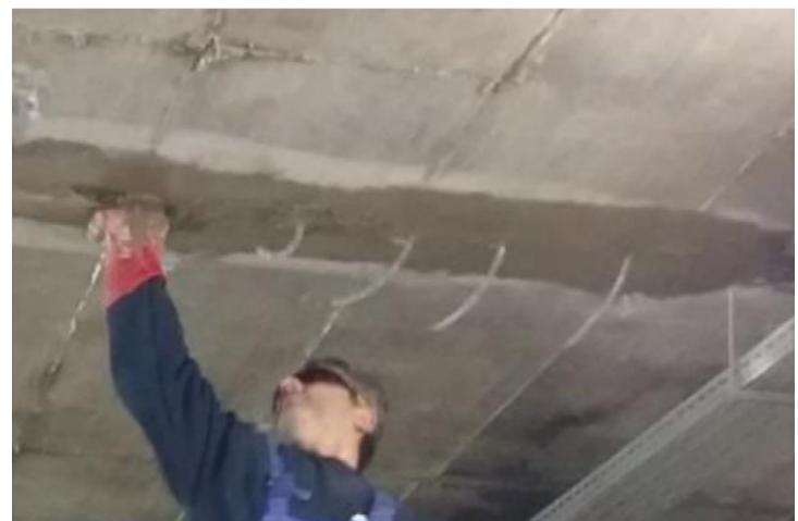
**Mešanje PENETRON® GROUT INJECT:** Pomešajte 6-6,5 litara čiste vode sa jednom vrećom od 25 kg PENETRON® GROUT INJECT. Mešajte mikserom na maloj brzini približno 2-3 minuta, dok se ne formira glatka i homogena masa, bez grudvica. U slučaju da nam je potrebna ekstremno niska viskoznost (popunjavanje veoma tankih prslina), treba dodati još malo vode (oko 0,5 lit), tako da se dobije viskoznost od 18 DIN-sekundi. Kad smo postigli zahtevanu fluidnost, masa je spremna za ubrizgavanje pomoću pumpe.
