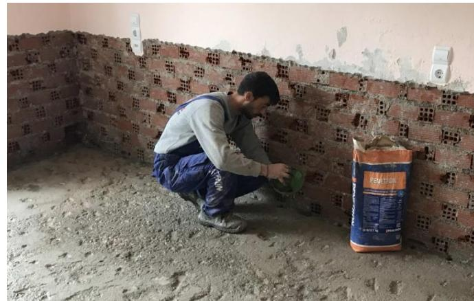
Sledećeg dana, po vezivanju reparturnih materijala, pripremljena površina mora da se dobro navlaži pre nanošenja polimer-cementnog hidroizolacionog premaza PENETRON® SEALCOAT™ ELASTIC ili FLEX. Prvi sloj se nanosi zidarskom četkom na vertikalne površine, na sastav zida i poda, kao i na deo poda. U taj sloj se utapa alkalno otporna armatura mrežica FIBERGLASS MESH (otvori 5 x 5 mm). Sledećeg dana se nanosi drugi sloj.
