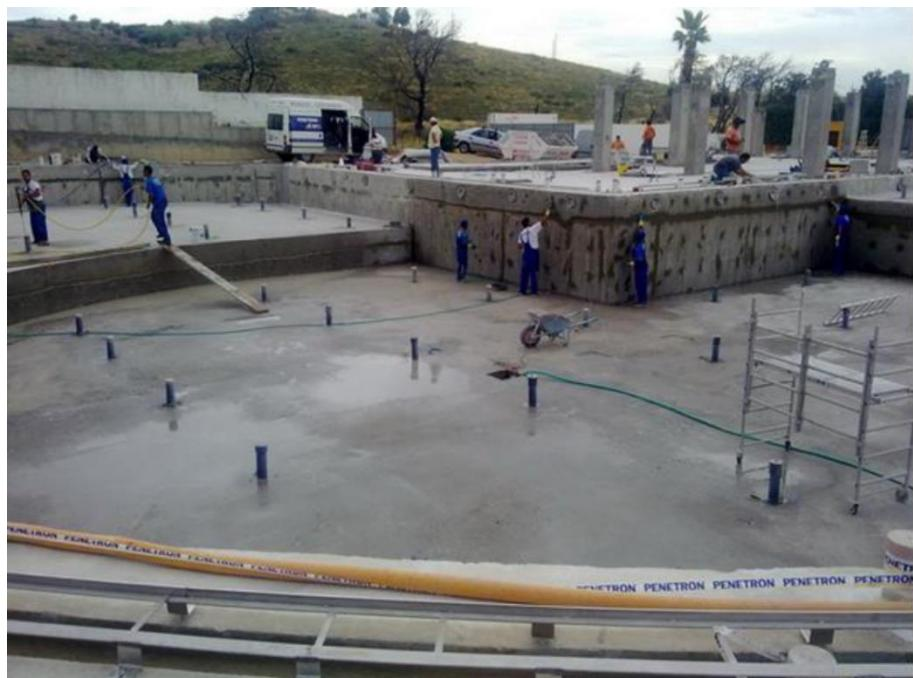
Kad su u pitanju prodori za cevi i druge instalacije bazenske tehnike, tu se koristi kružno postavljanje hidroizolacionih bubrećih traka PENEBAR® SW (preporučena je upotreba trake sa odloženom reakcijom PENEBAR® SW tip B, a ponekad, zavisno od dimenzije prodora, tip B presečen na pola). PENEBAR® SW se postavlja u dubinu najmanje 5 cm od površine betona i pokriva kristališućim brzovezujućim malterom PENEPLUG®.
