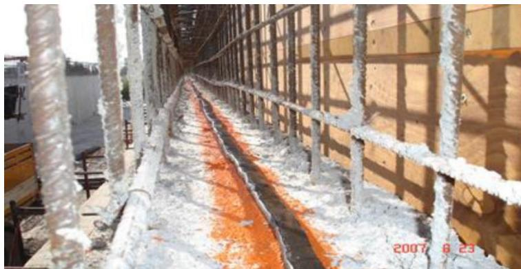
U betonskim elementima koji su tanji od 20 cm koristi se PENEBAR® SW tip B (rolne od 4 m, presek 25 x 9 mm), dok se PENEBAR® SW tip A koristi u betonskim elementima debljim od 20 cm (rolna 5 m, presek 25 x 19 mm).
