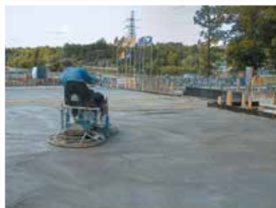
PENETRON® PLUS prah se posipa, a potom utrljava helikopterom
