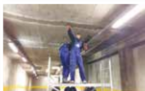
Aplikacija PENETRON® INJECT, kristališućeg sistema za injektiranje
