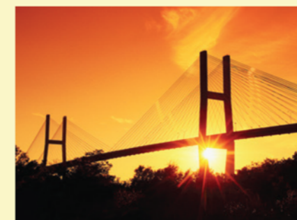
Mostovi i nadvožnjaci
