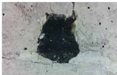
Uvećani pogled na presek betona koji pokazuje nabubrelu traku PENEBAR SW.
