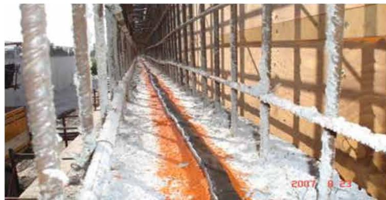
U betonskim elementima tanjim od 20 cm koristi se PENEBAR™ SW tip B (rolne od 4 m, presek 25 x 9 mm), dok se PENEBAR™ SW tip A koristi u betonskim elementima debljim od 20 cm (rolna 5 metara, presek 25 x 19 mm).
